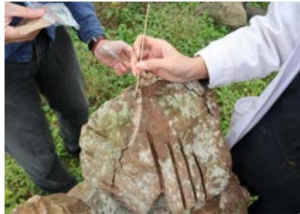
修護師於石雕開裂縫隙填補修護用填充材料。
