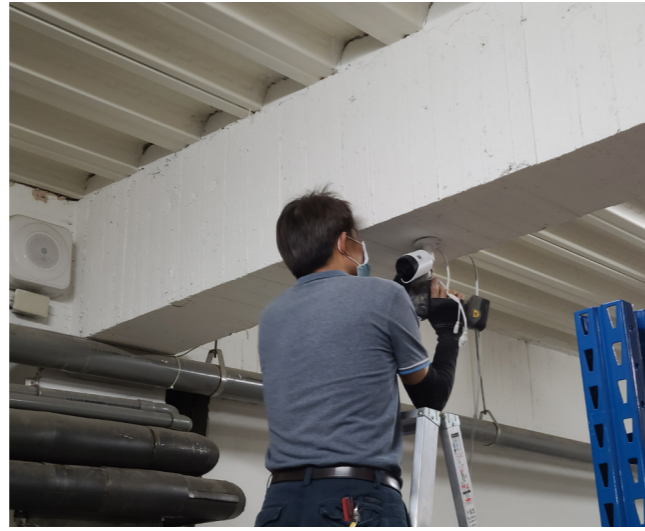
監視系統安裝。
