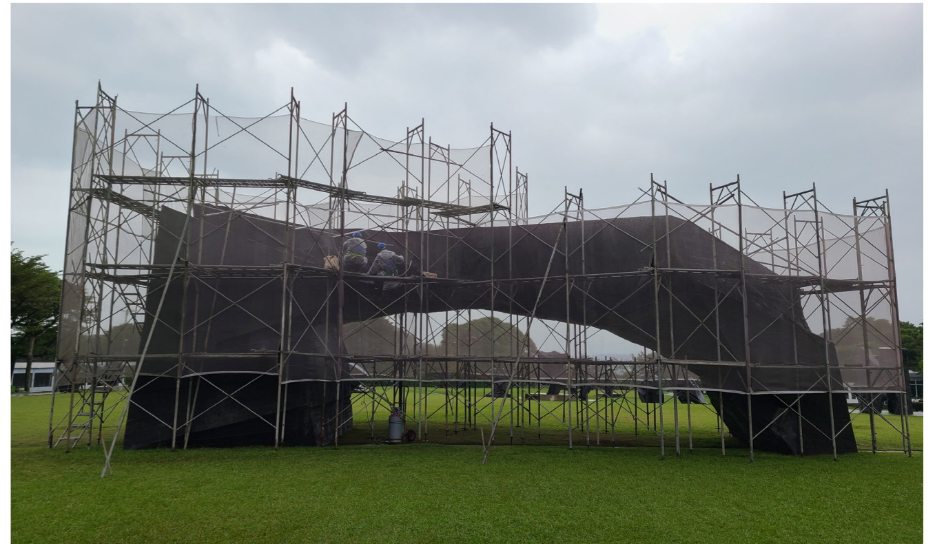
<太極系列—太極拱門>修復鷹架搭設。
