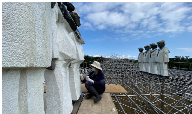
使用耐候性較佳的全色材料修護。
