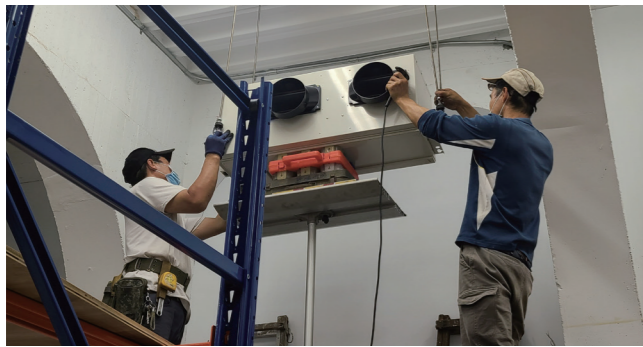
設置吊隱式除濕機。
