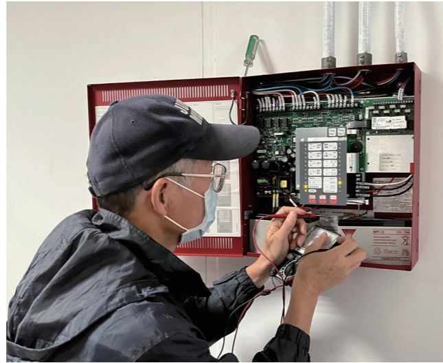
FM 200滅火系統電池檢查。
